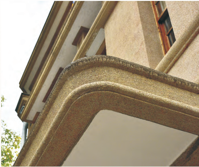
圖中的兩遮與飾帶皆是當時珍貴鋼筋混凝土結構。
